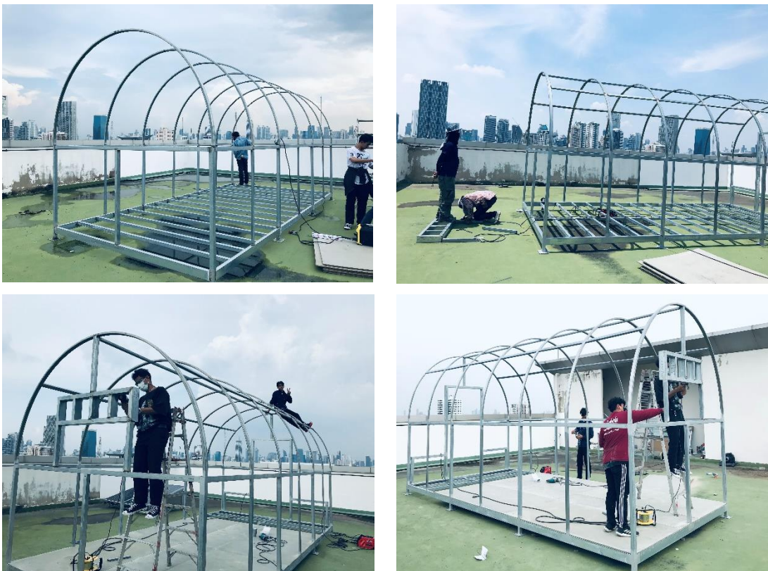
ภาพที่ 4.1 การประกอบโครงสร้างของโดมพลังงานแสงอาทิตย์
