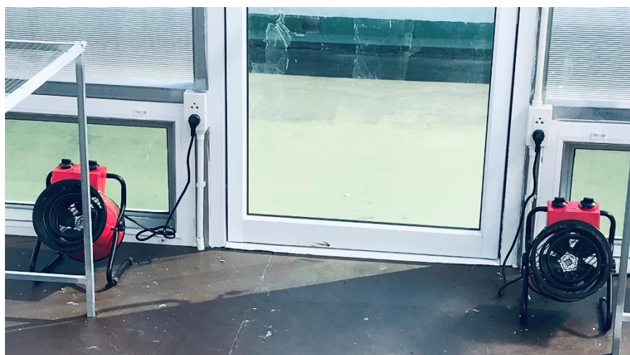
ภาพที่ 4.4 ติดตั้งพัดลมความร้อนช่วยเสริมพลังงานจากแสงอาทิตย์
